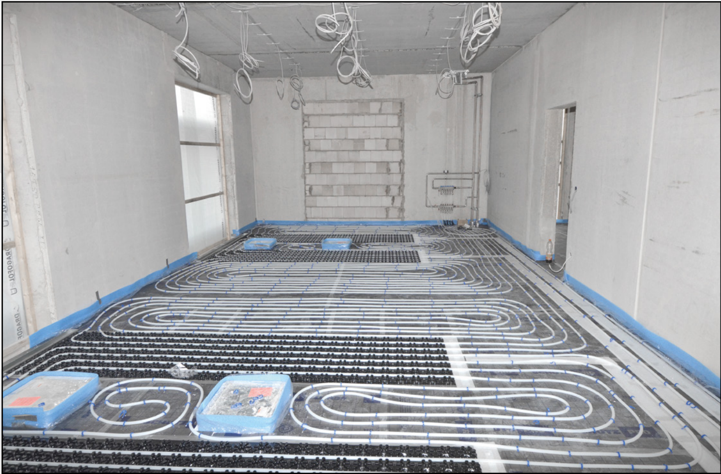
Montaje de los niveles de canalización y de suelo radiante previos al recubrimiento con mortero
