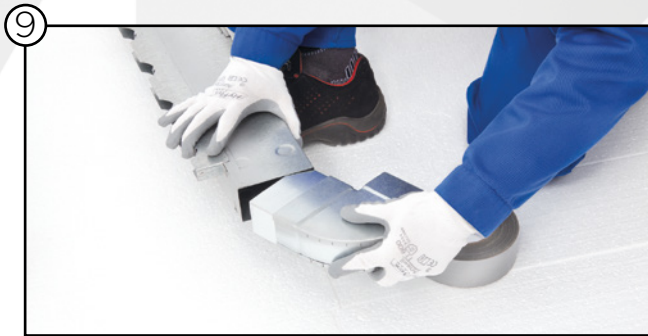
Montaje de codos del sistema de canalización
