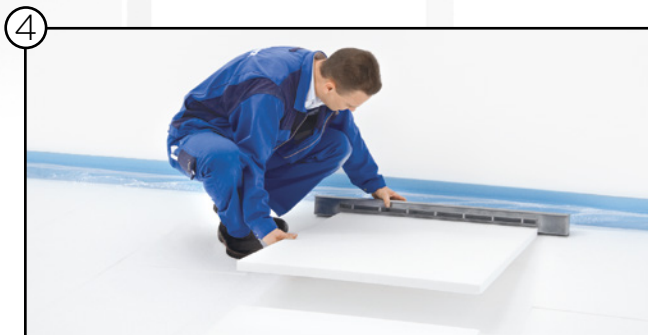
Montar paneles distanciadores al módulo de impulsión
