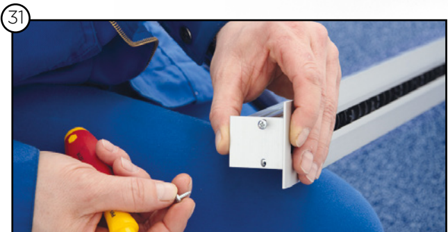
31 Montar el perfil de acabado del módulo de impulsión
