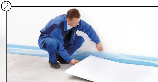
Colocar el aislamiento acústico
