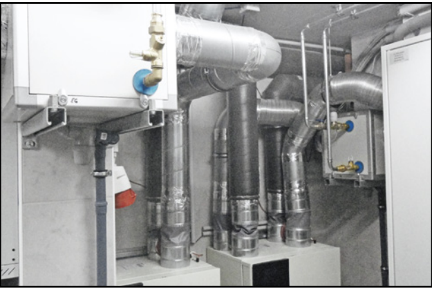
Equipo de ventilación integrado en el techo para ventilación de vivienda con equipo de enfriamiento
