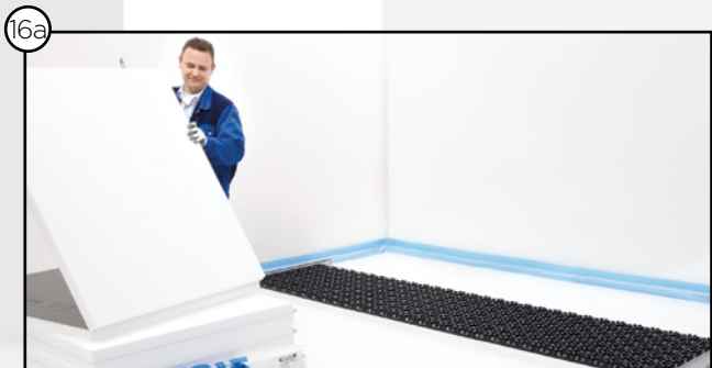
Colocar los paneles para la fijación de circuitos
