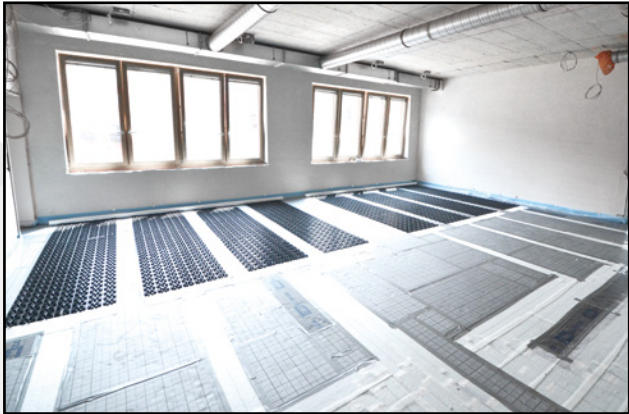
Montaje AIRCONOMY® previo a la formación de circuitos
