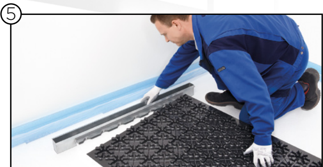
Encajar el módulo AIRCONOMY® en la caja de impulsión
