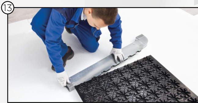
Encajar el módulo de distribución en el panel AIRCONOMY®
