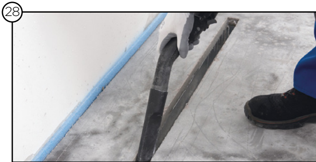
28 Limpieza del módulo de impulsión de aire
