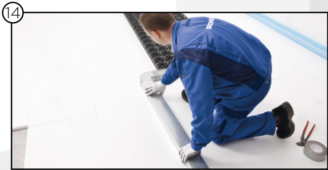
Montar y sellar el resto de los elementos planos de canalización de aire
