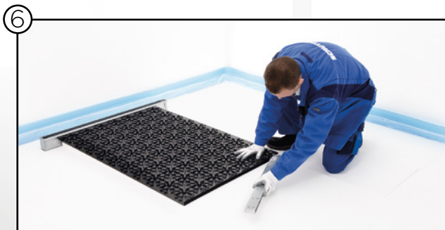
Montar el elemento de conexión
