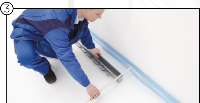
Colocar las cajas de impulsión de aire
