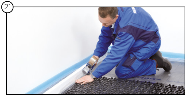
Sellado del módulo de montaje provisional
