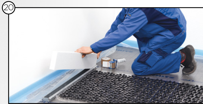
Colocación del módulo de montaje provisional y preventivo
