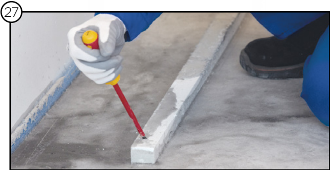
27 Eliminación del módulo provisional
