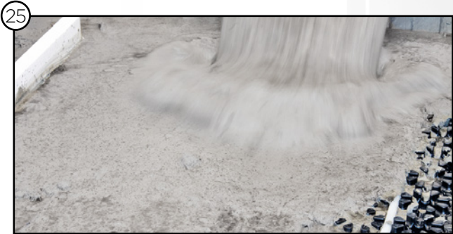
25 Aplicación del mortero
