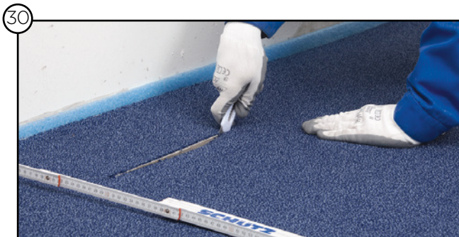
30 En el caso de acabado de moqueta, cortar ésta para descubrir el módulo de impulsión.
