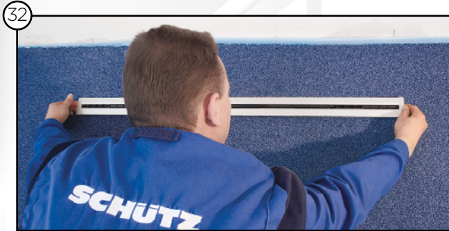
32 Montar los perfiles
