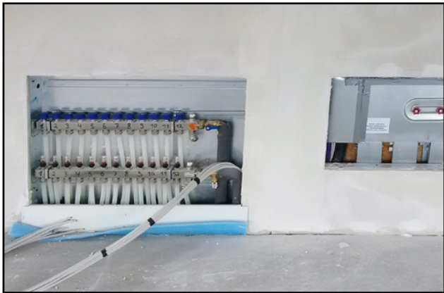
Colector de suelo radiante y distribuidor de aire
