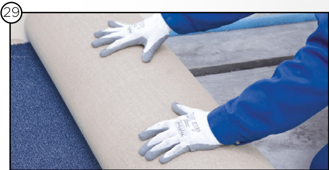
29 Aplicación del acabado de suelo
