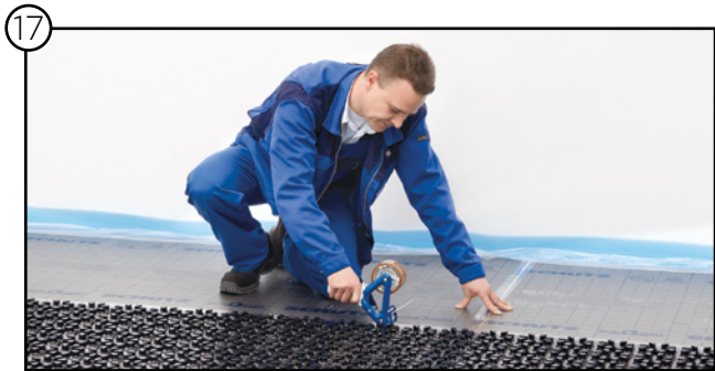
Sellar las uniones de paneles y el babero de la cinta perimetral
