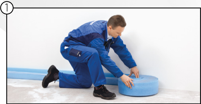
Colocar la banda perimetral
